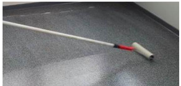
Auftrag der Versiegelung mit der Walze längs und quer gleichmäßig dünn.
